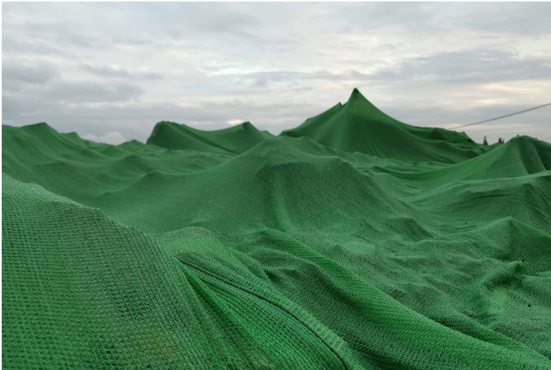
绿色塑料布遮盖的建筑废弃物。
